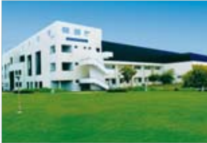
Chennai plant(インド)
